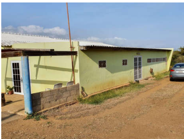
Achterkant van de woning
