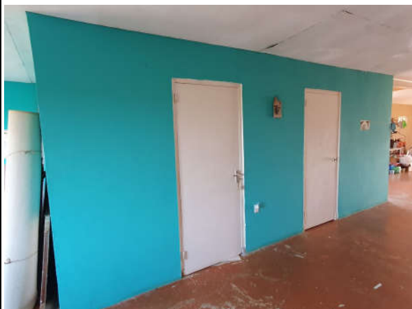
Entree naar een toilet en bergruimte
