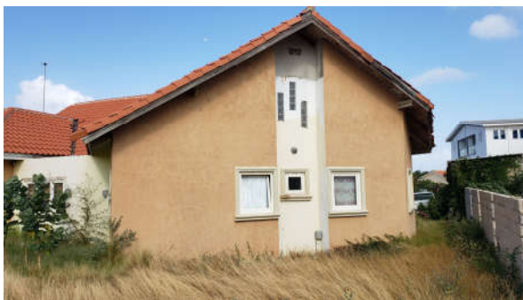
Gedeelte van de rechter / vorgevel
