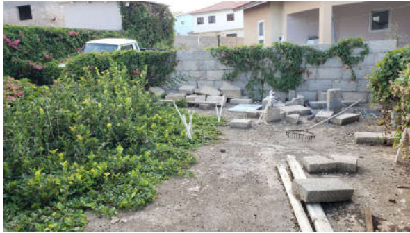
Fundering en beganegrono vloer voor appt. in de achtertuin
