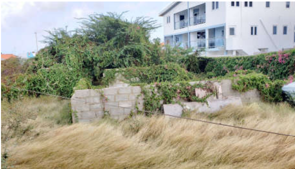
Opgetrokken muren bij de onafgebouwde appt. in de achtertuin
