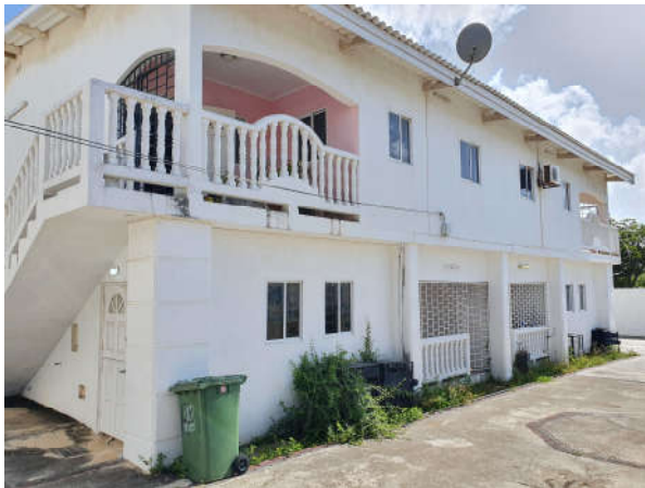
Voorgevel gebouw aan de achterkant (Gebouw II)
